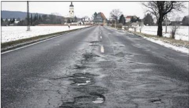
Flickentepich: Schlaglöcher auf der Straße Apfelstädt-Wandersleben sind notdürftig geflickt und reißen wie vielerorts immer wieder auf. Die holprigste Piste im Kreis wird jetzt gesucht. Foto: Wieland Fischer
