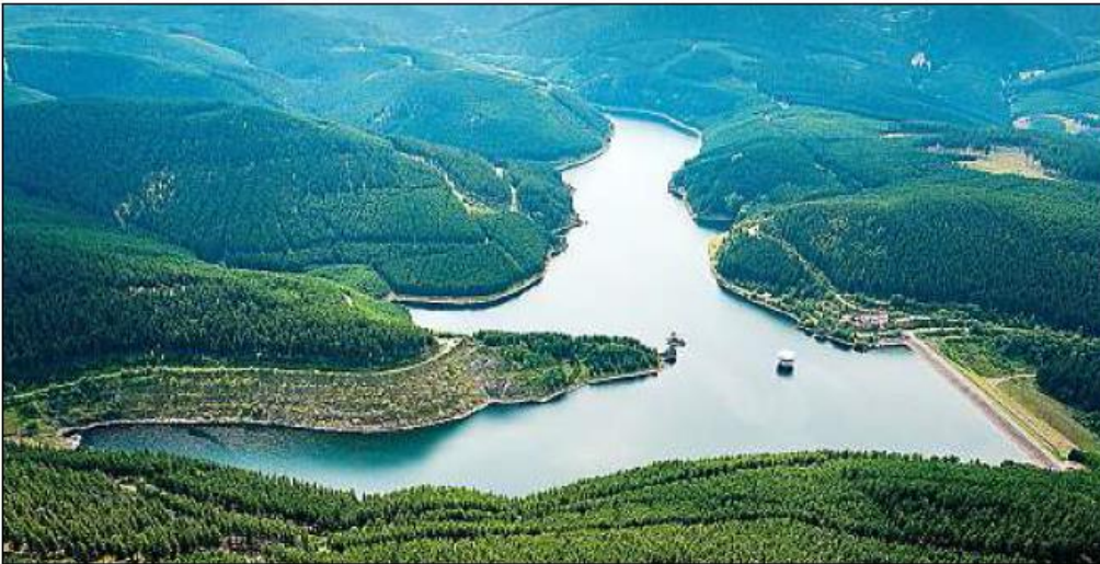
Die Talsperre Schmalwasser bei Tambach-Dietharz soll als Unterbecken für das geplante Pumpspeicherwerk dienen. Nach Fertigstellung soll es mit rund 1000 Megawatt Leistung zu den größten Kraftwerken seiner Art in Deutschland gehören. Foto: Sascha Fromm
